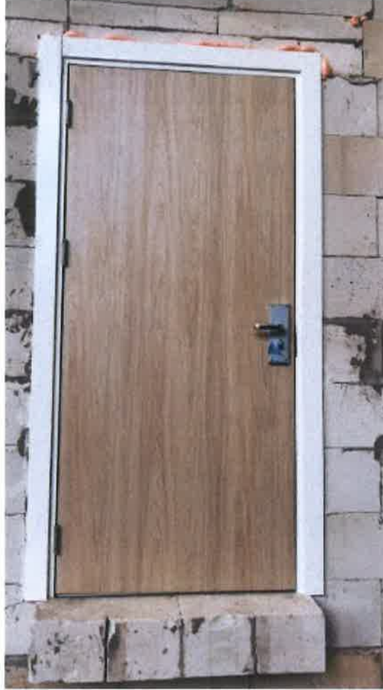
Şekil 20. Deney Öncesi Maruz Kalan Yüzey Görünüşü
