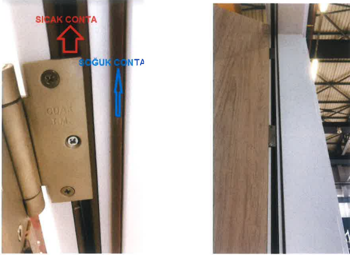
Şekil 5-6. Menteşe ve Kasa Üzerindeki Contalar
